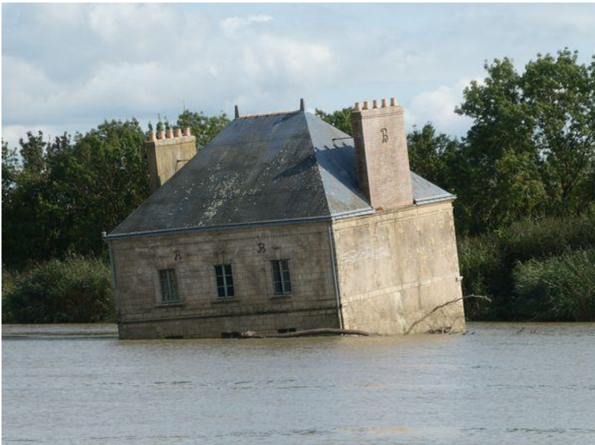
Huis dat door afkalving van de oever in de Loire is beland.
