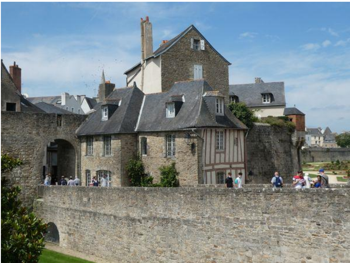
Middeleeuwse huizen bij één van de stadspoorten van Vannes.
