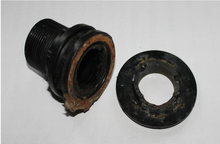
De doorvoer van het log is bij de flens afgescheurd.
