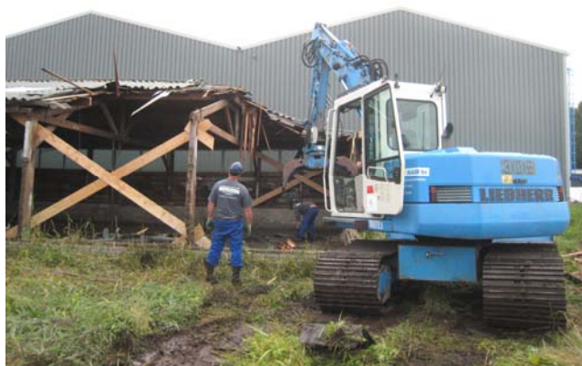
De Liebherr van Cor Nap ruimt op
