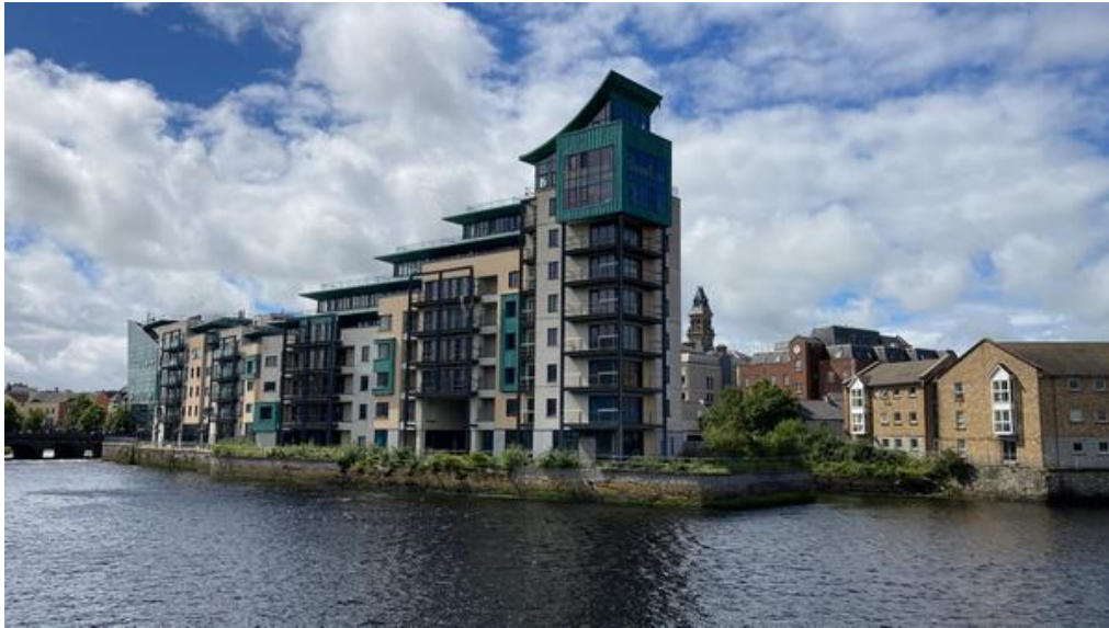
Nieuwbouw vlak voor het oude stadscentrum van Sligo.
