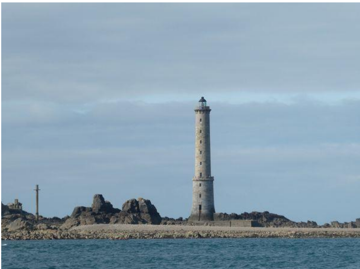
De vuurtoren op het laatste rotseilandje.
